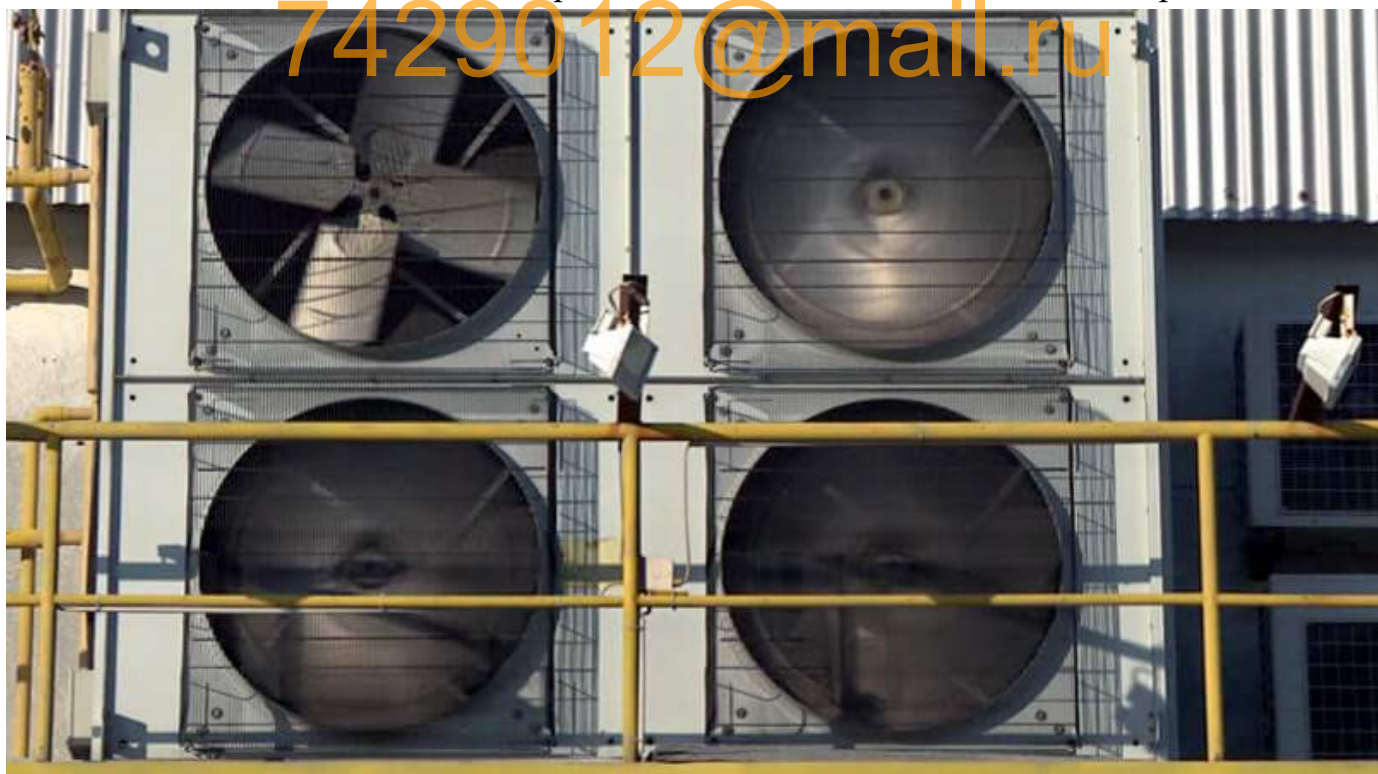
Наружный блок промышленного центрального кондиционера
